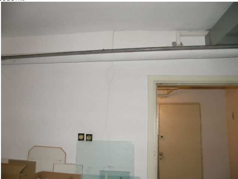
Rys. nr 4. Pęknięcie ściany działowej w osi 22.
